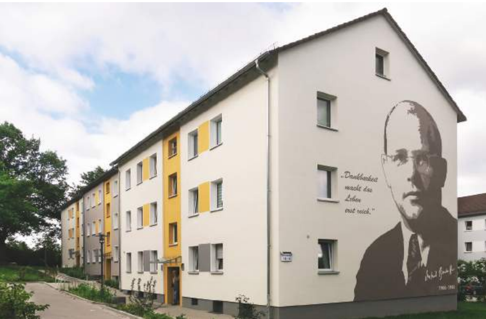
Bis 2023 werden die 264 Bestandswohnungen der Unternehmensgruppe Nassauische Heimstätte | Wohnstadt im Fuldaer Stadtteil Ziehers-Nord energetisch modernisiert. In der Bonhoefferstraße 18 bis 22 sind die Arbeiten bereits abgeschlossen.
